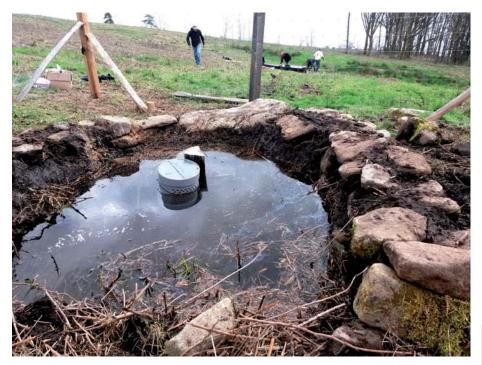
Un abreuvoir (au second plan) installé avec un Filtre décanteur ® placé dans une pêcherie – S.Massy ; Syndicat le Lac de Vassivière-
