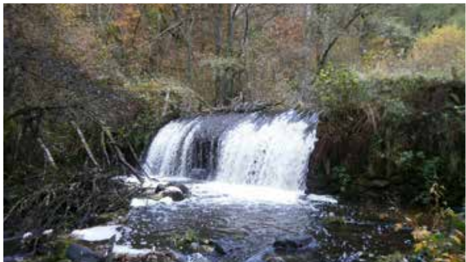
Ancien moulin sur le Thaurion faisant l'objet d'une étude pour la restauration de la continuité écologique (CIATE)
