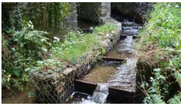
Mise en place de prébarrages pour franchissement d'un obstacle (Syndicat Monts et Barrages)
