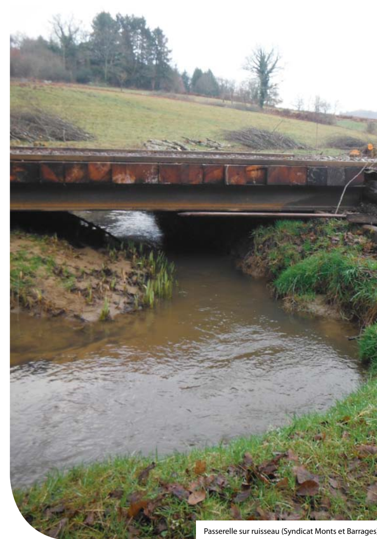
Passerelle sur ruisseau (Syndicat Monts et Barrages)
