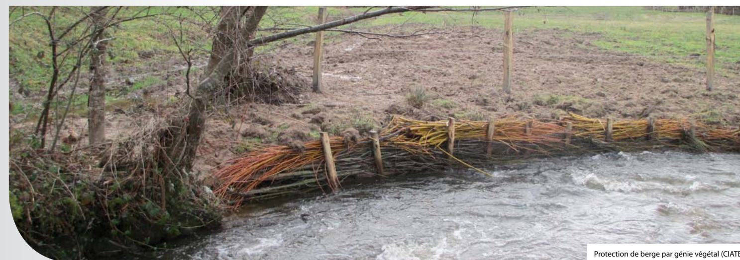
Protection de berge par génie végétal (CIATE)
