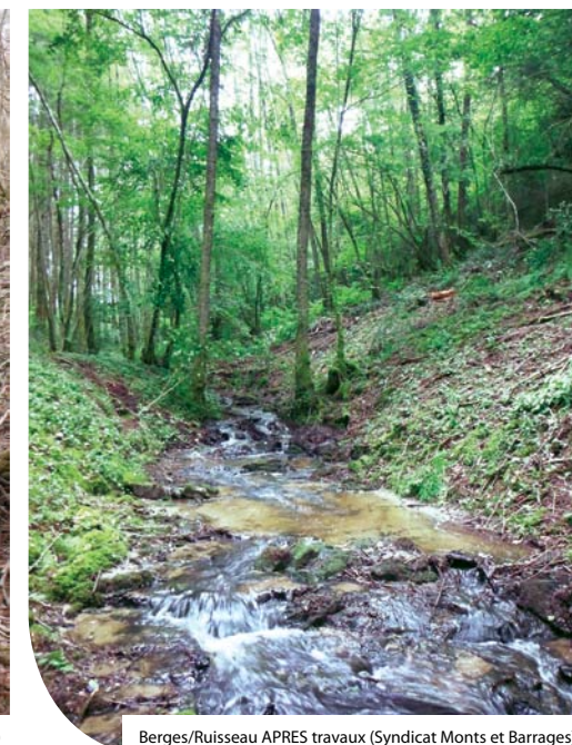
Berges/Ruisseau APRES travaux (Syndicat Monts et Barrages)
