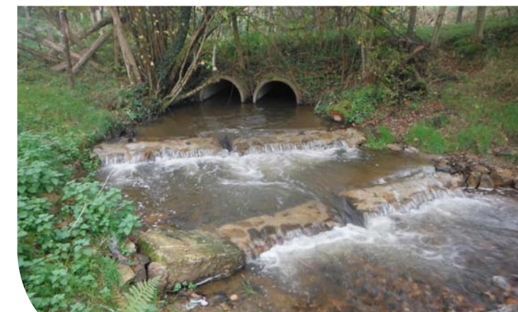
Franchissement d'une buse par installation de prébarrages (Syndicat Monts et Barrages)
