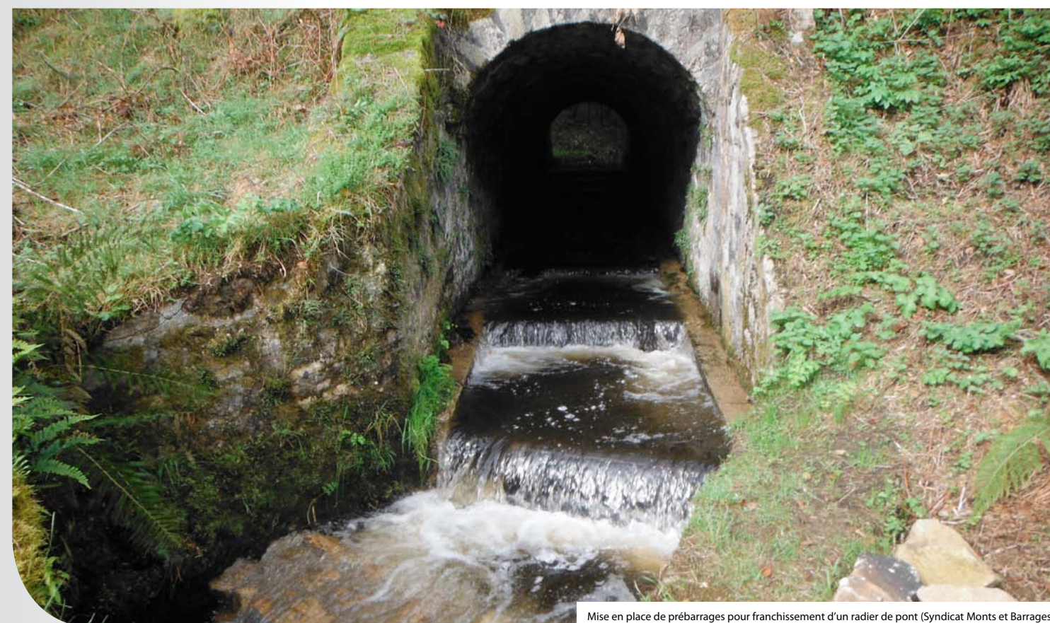
Mise en place de prébarrages pour franchissement d'un radier de pont (Syndicat Monts et Barrages)
