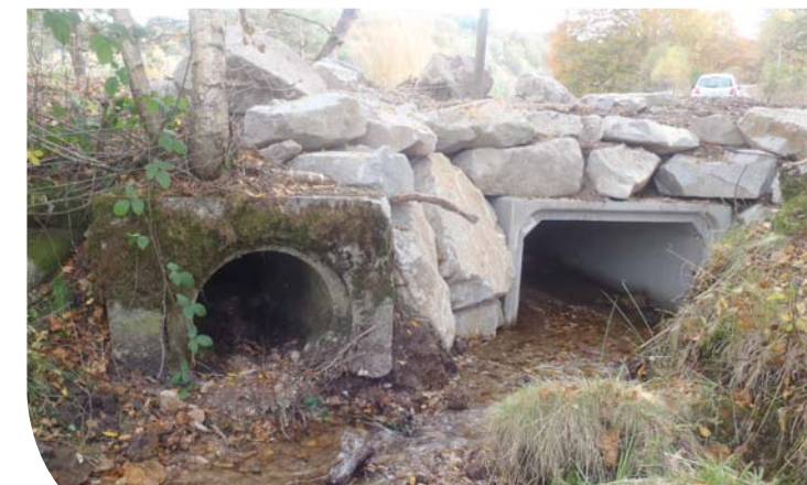
Franchissement de cours d'eau par une buse cadre (Fédération de pêche de la Corrèze)
