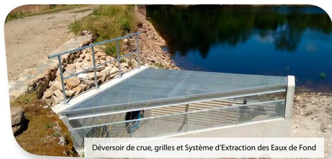
Déversoir de crue, grilles et Système d'Extraction des Eaux de Fond
