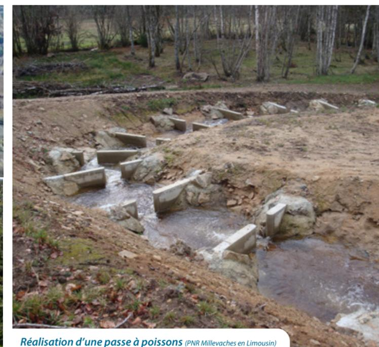
Réalisation d'une passe à poissons (PNR Millevaches en Limousin)
