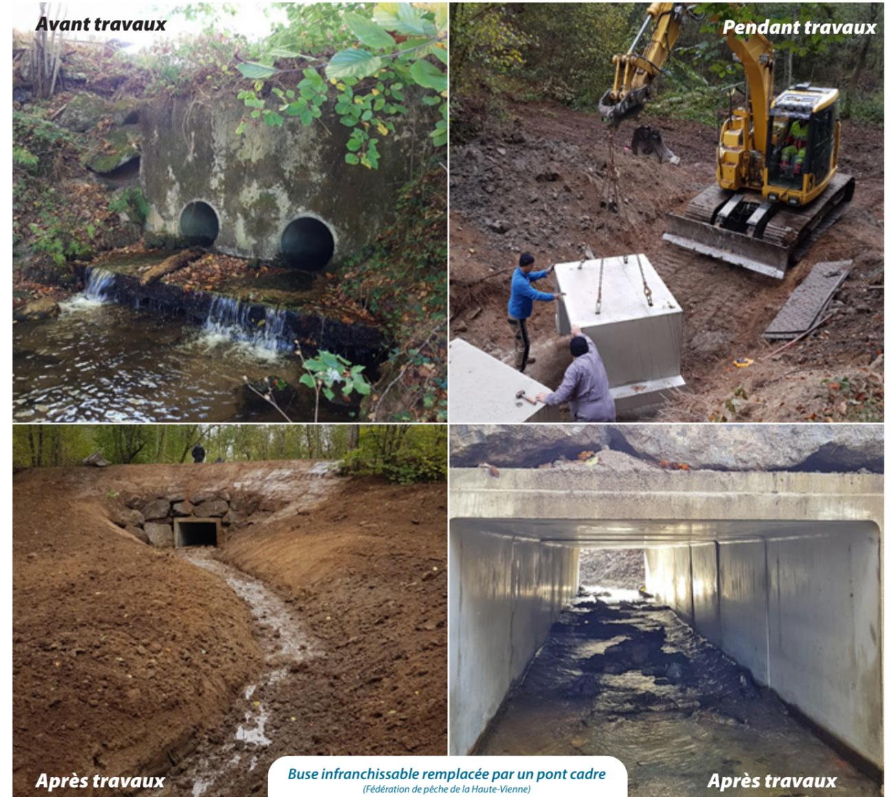
Buse infranchissable remplacée par un pont cadre
