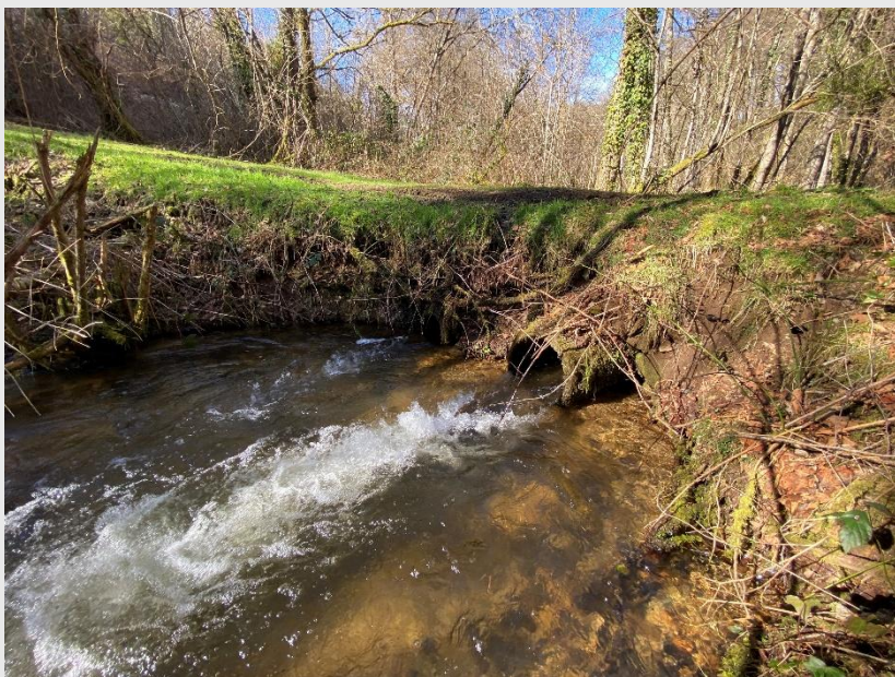
Buse sous chemin communal avant travaux
