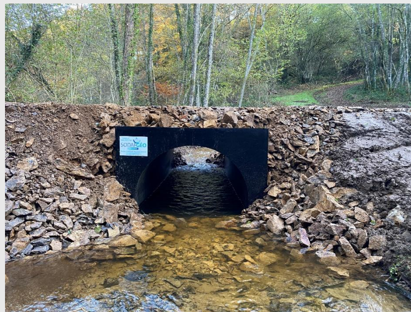
Buse sous chemin communal après travaux
