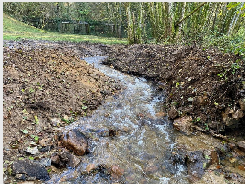
Buse parcelle privée après travaux
