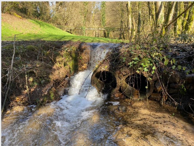
Buse parcelle privée avant travaux
